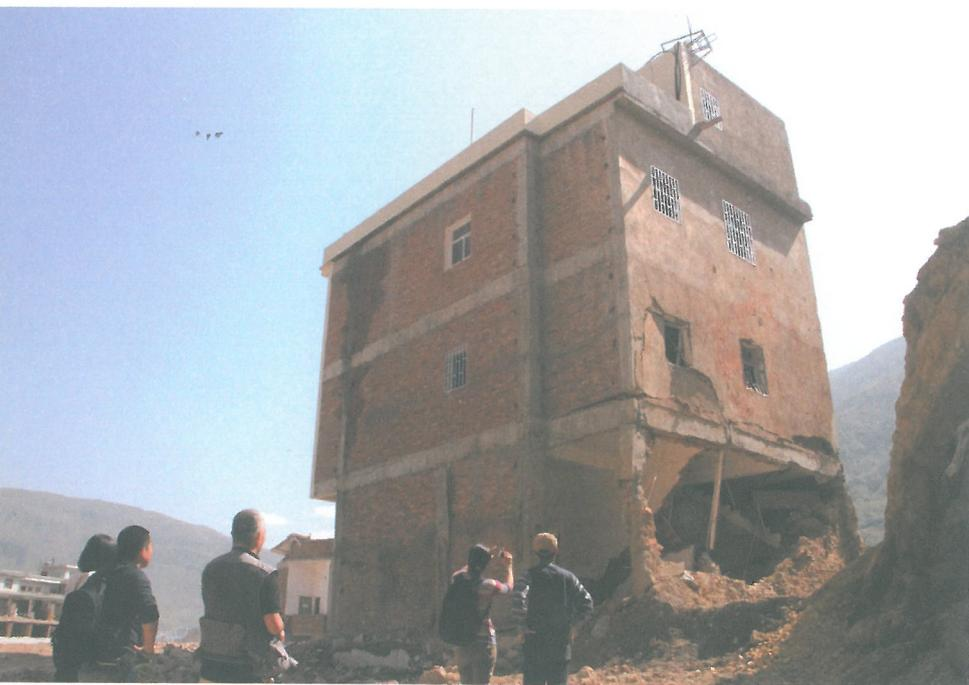
2008 年底動工興建樣板房，3 個月後竣工，趕及農曆新年前讓一對公公婆婆入住。房子可以抵禦 7 度地震（中國震度標準，約等於黎克特制 6 級），當場搖晃果然不倒，假設汶川大地震重臨，震央達 9 度，偏遠地區大抵 7 度，此屋也能屹立，就算倒下也有 10 至 15 分鐘逃生時間。
